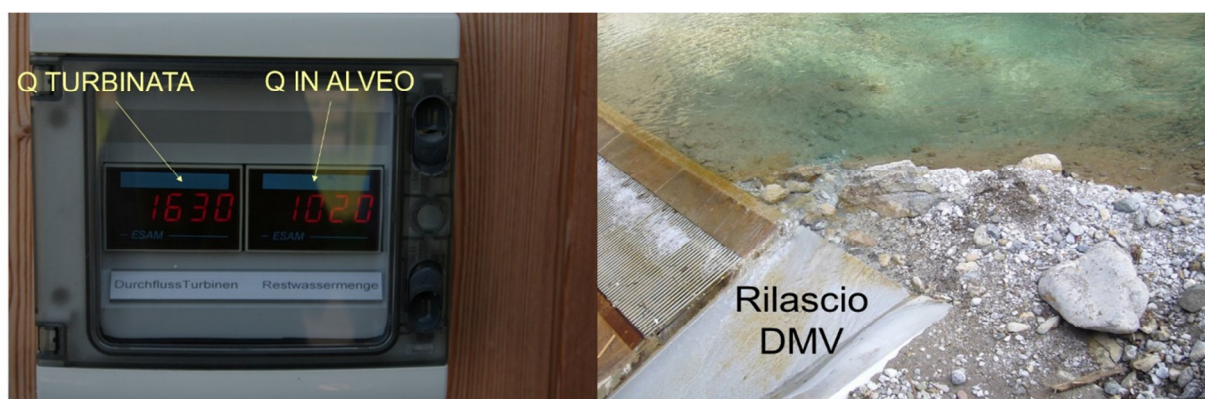
Figura 6 – A sinistra: un esempio “virtuoso” di sistema con display riportante il dato istantaneo delle portate turbinate e rilasciate posto vicino all’opera di presa. A destra: esempio di mancato rispetto degli obblighi di rilascio del DMV (occlusione del tratto di sezione adibito al DMV)
