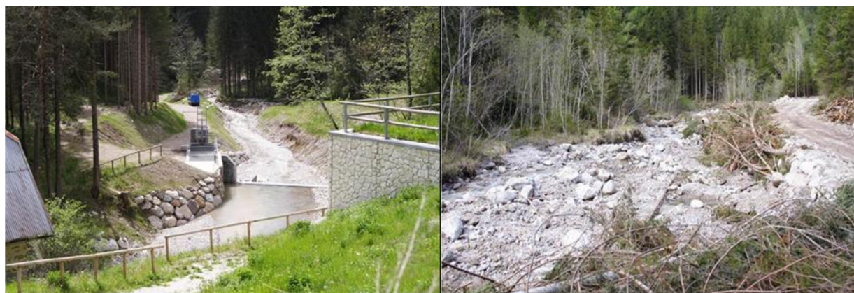
Figura 20 – Torrente Piova (provincia di Belluno): nella foto a sinistra un tratto posto a valle di un'opera di presa recentemente realizzata (visibile sulla parte sinistra della foto) e posta immediatamente a valle dell'opera di rilascio di un altro impianto di cui è visibile una porzione della centrale di produzione (muro sulla destra della foto). Nel tratto a monte, sono in corso di realizzazione altri due impianti (nella foto a destra la costruzione della strada di accesso), per complessivi 4 impianti contigui su un unico corpo idrico.
